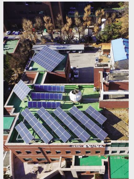
협동조합 형태로 서울시 시험연구소에 설치된 태양광발전소.
